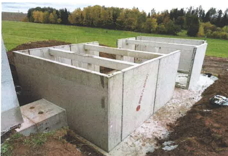
Výstavba nové akumulční komory a rekonstrukce čerpací stanice Domeček pod Jiráskovou chatou - Lipí
