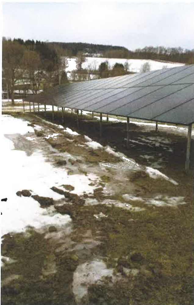
Výstavba FVE ČOV Teplice nad Metují.
