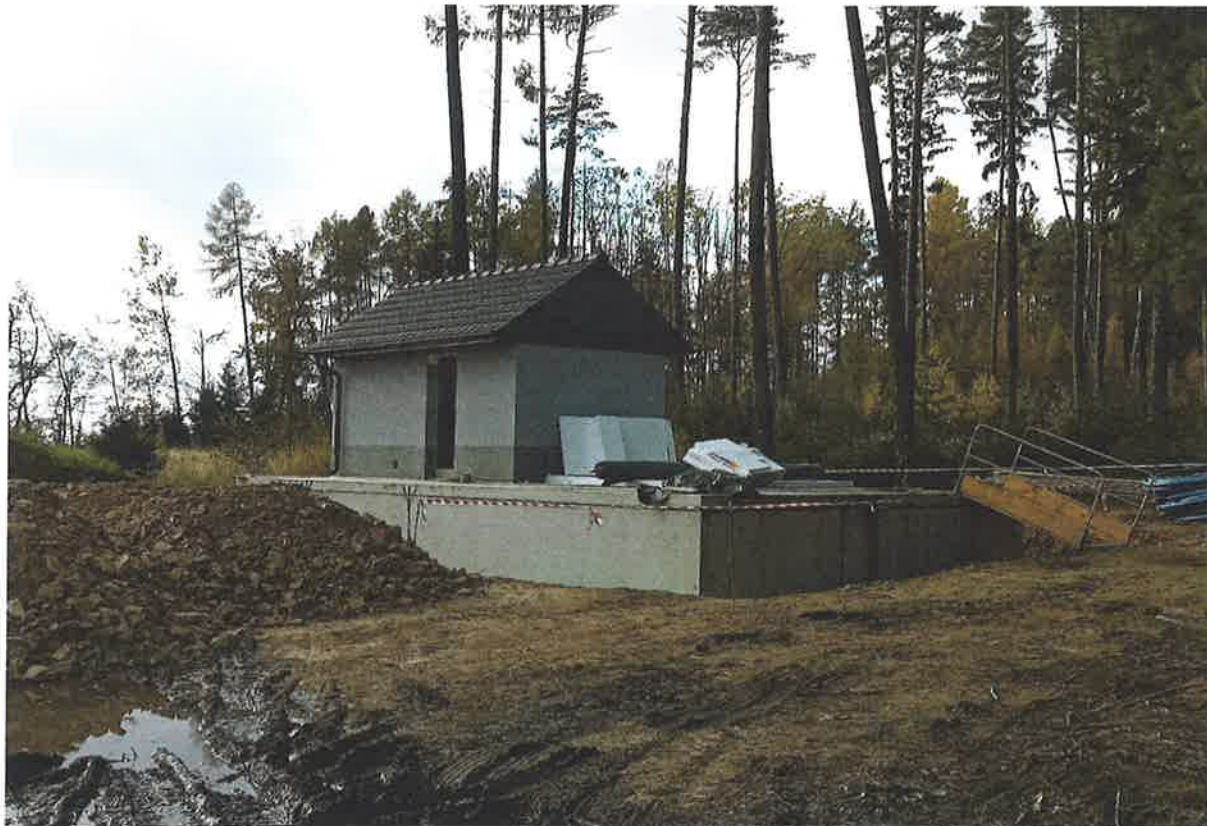
Výstavba nového vodojemu Chvalkovice – Výhled
