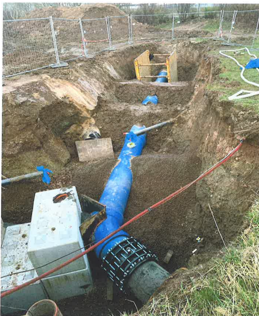
Rekonstrukce přivaděče VSVČ – Běloves
