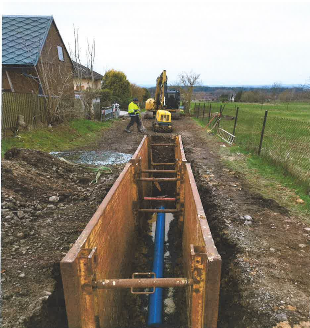
Výstavba nového vodovodu Chvalkovice - Výhled
