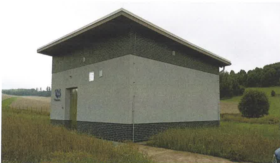
Rekonstrukce objektu na přivaděči VSVC Na Plachtách Police nad Metují.
