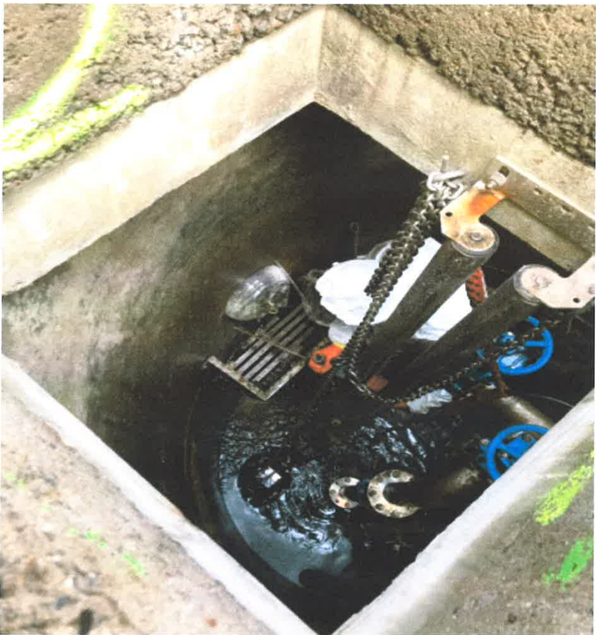
Rekonstrukce čerpací stanice na kanalizaci Lipí
